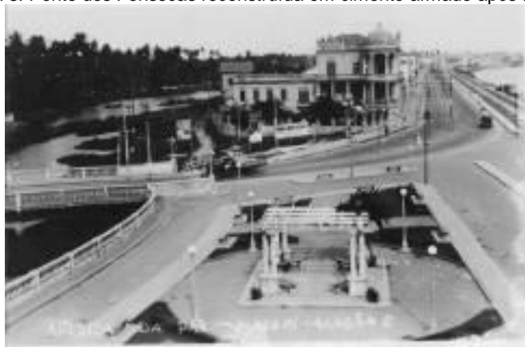
Figura 3: Ponte dos Fonseca reconstruída em cimento armado após a cheia.
